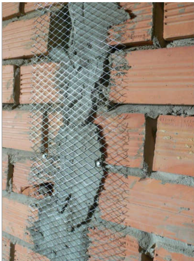
Trám vữa, các vết nứt trên tường gạch, đóng lưới liên kết
