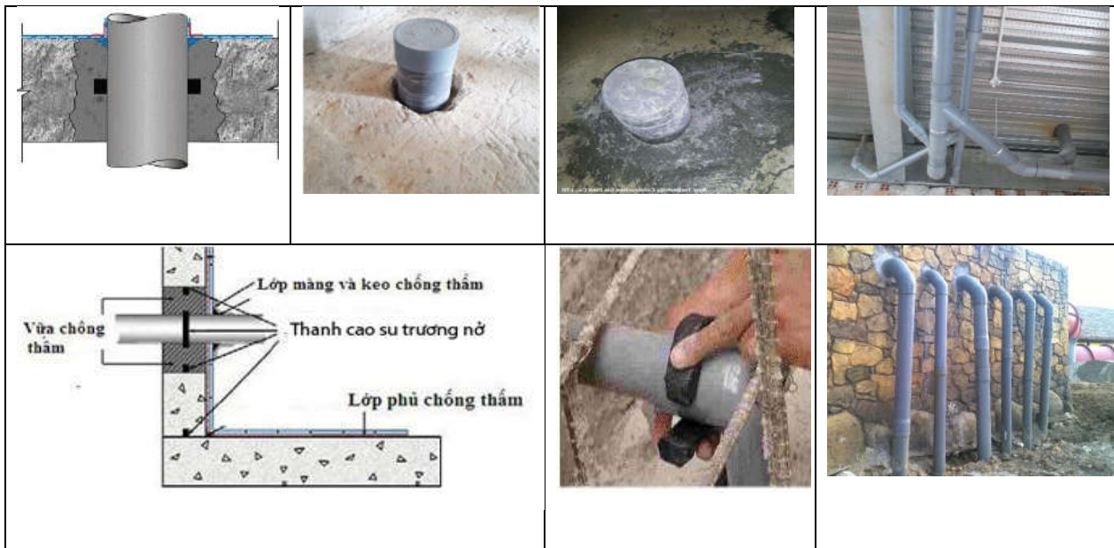
Lắp đặt ống uPVC âm tường
