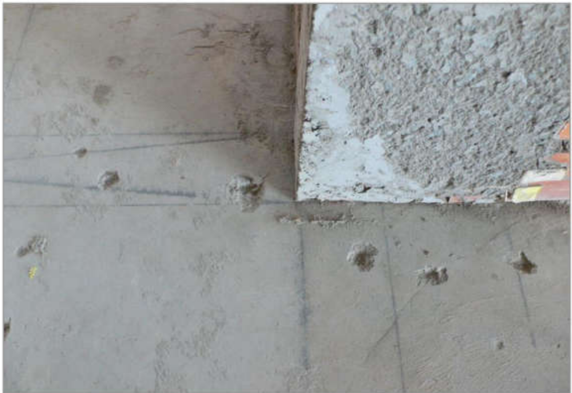
Trụ bê tông( cột kẹp) sau khi đổ.
