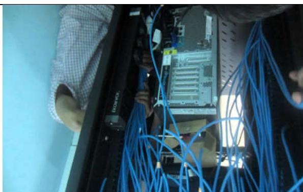
Sắp xếp dây ngăn nắp đai dây cẩn thận theo dọc theo tủ rack
