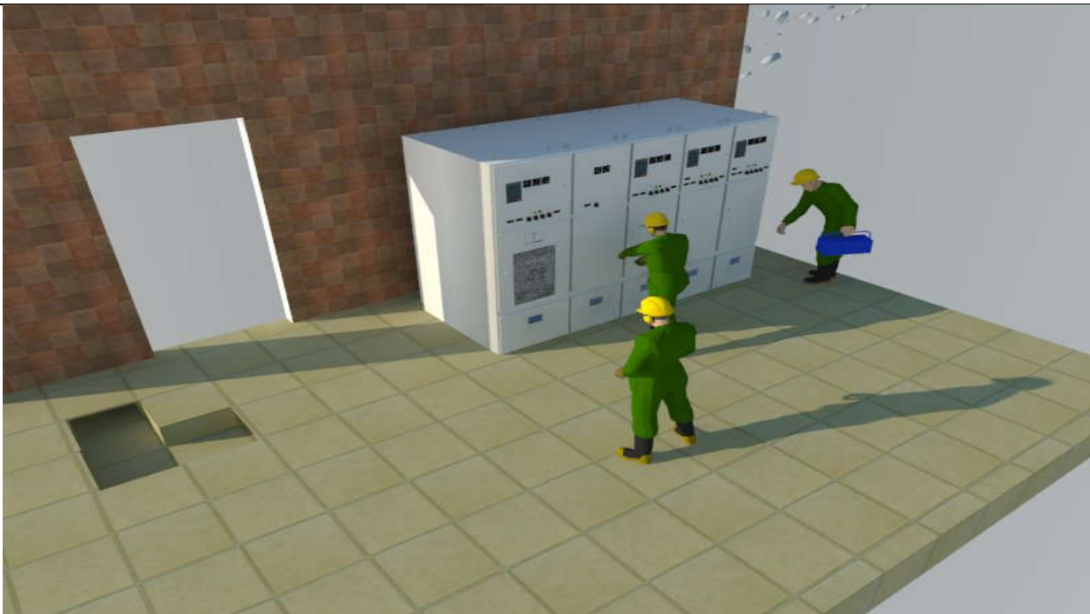
VẬN CHUYỂN TỦ ĐIỆN VÀO VỊ TRÍ
