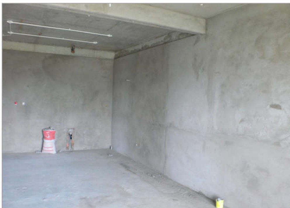
Kết thúc công việc tô trát, mặt trần, mặt tường, mặt sàn phải được vệ sinh sạch sẽ.
