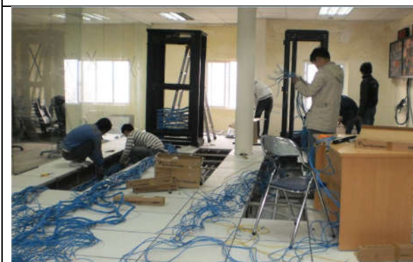
Trước khi đưa cáp vào tủ phải sắp xếp dây thẳng thăn , ngay ngắn
