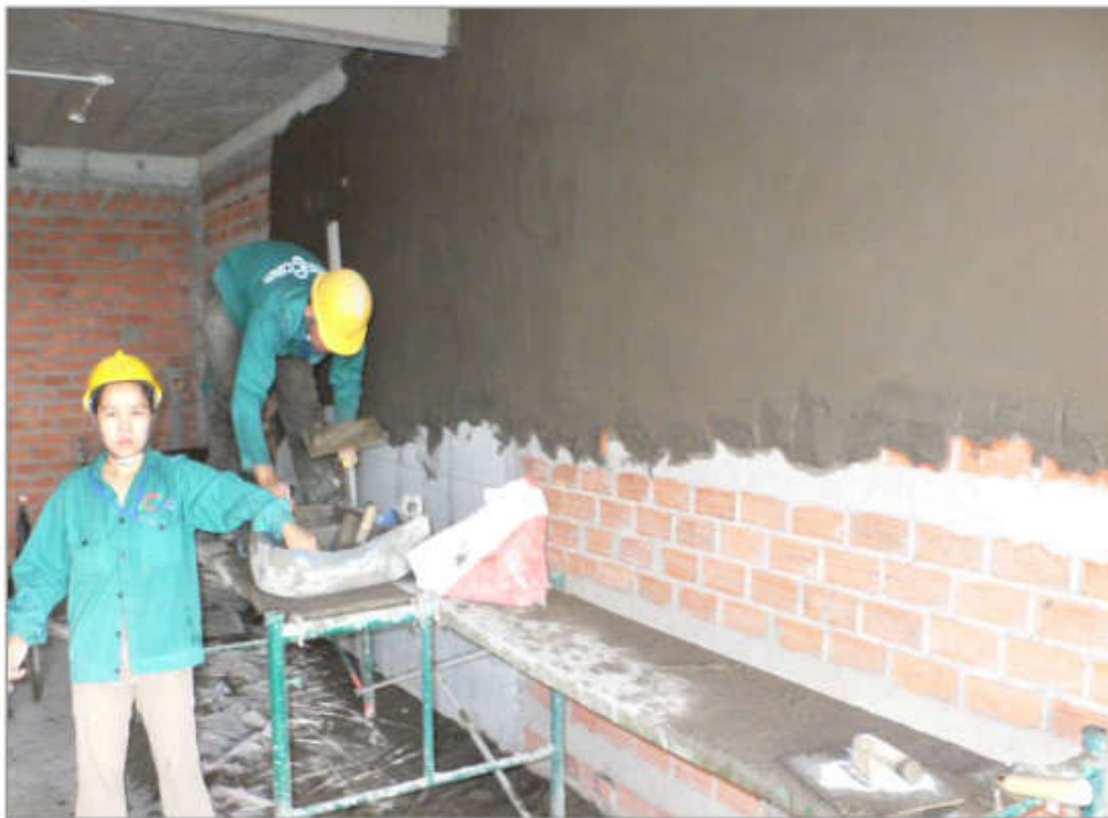
Trải bạt nilông dưới chân tường trước khi trát. Trát tường từ trên xuống dưới.
