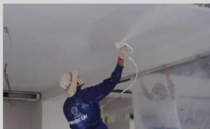
➤ Thi công bằng súng phun
