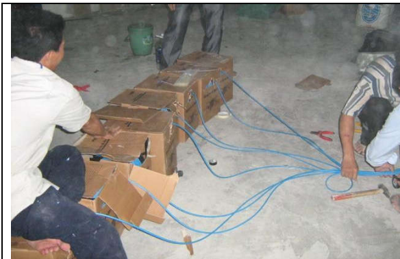
Đánh dấu các đầu cáp trước khi tiến hành kéo dây vào vị trí
