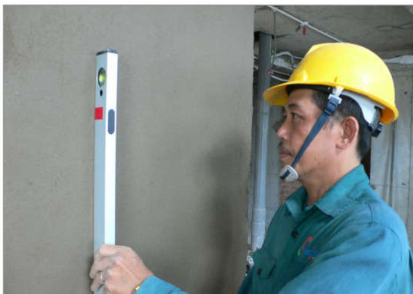
Sử dụng ni vô kiểm tra độ thẳng đứng của mặt tường trát.
